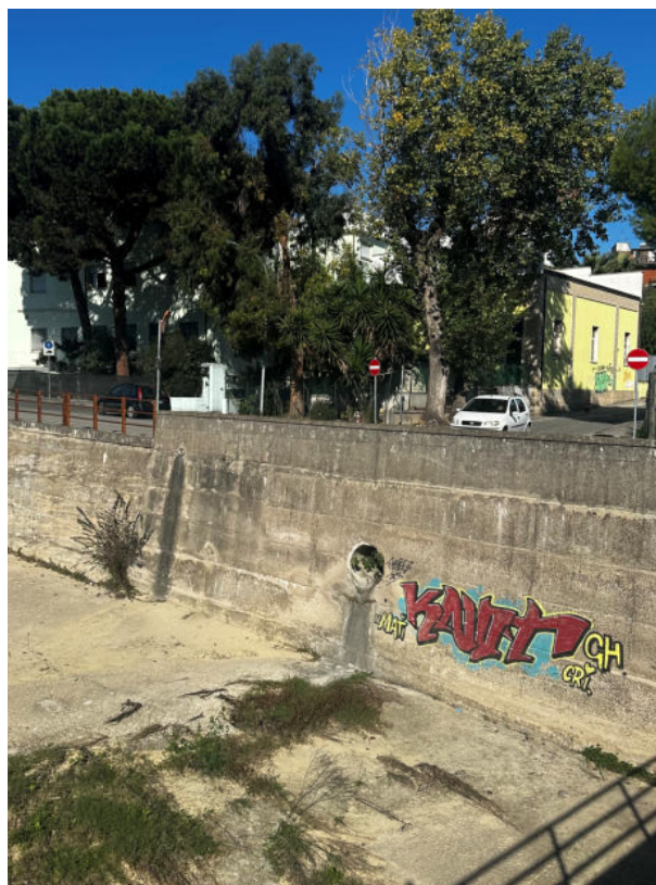
Fig.19-20 – Canali di scolo in corrispondenza del paramento in c.a. sulla sponda sn del T. Albula
