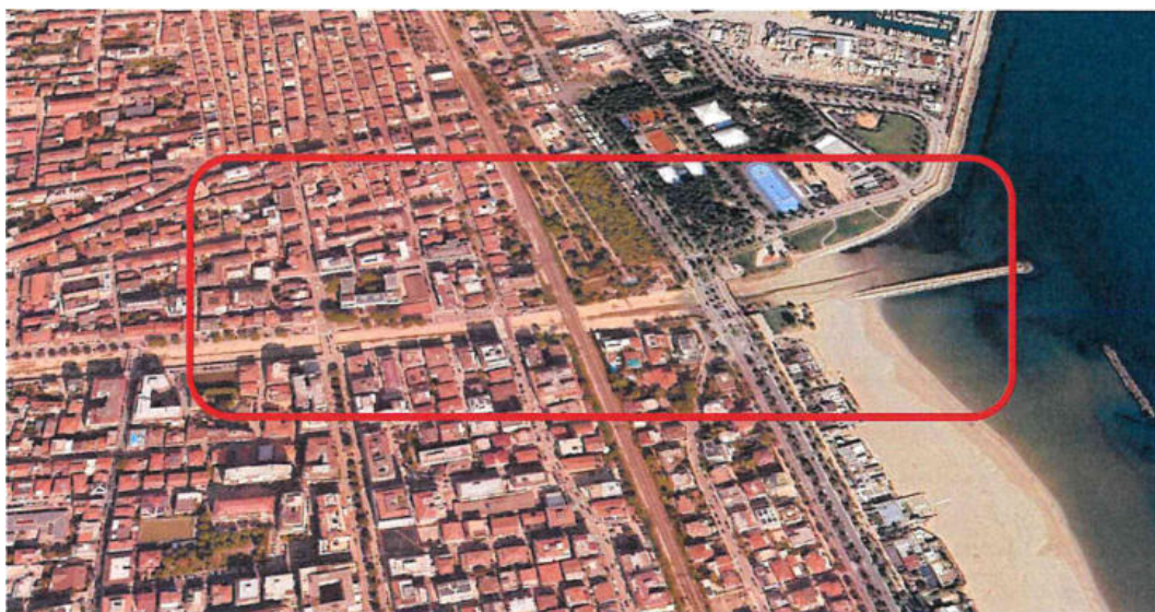
Fig.18 – Foto aerea con perimetrazione dell’area interessata dal DIP di riqualificazione della foce del T.Albula
