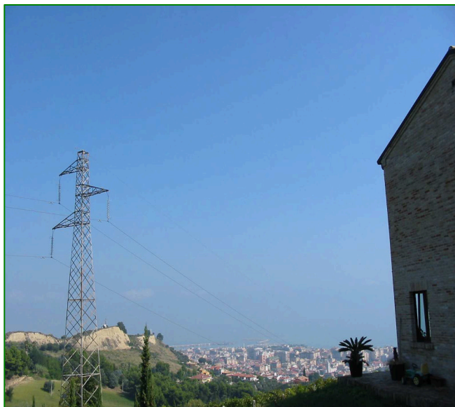
Vista abitazione ed elettrodotto
