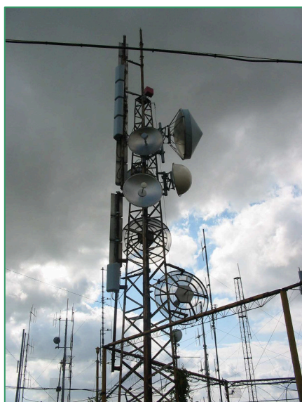
Figura 3: esempio di impianto televisivo con ponte radio.
