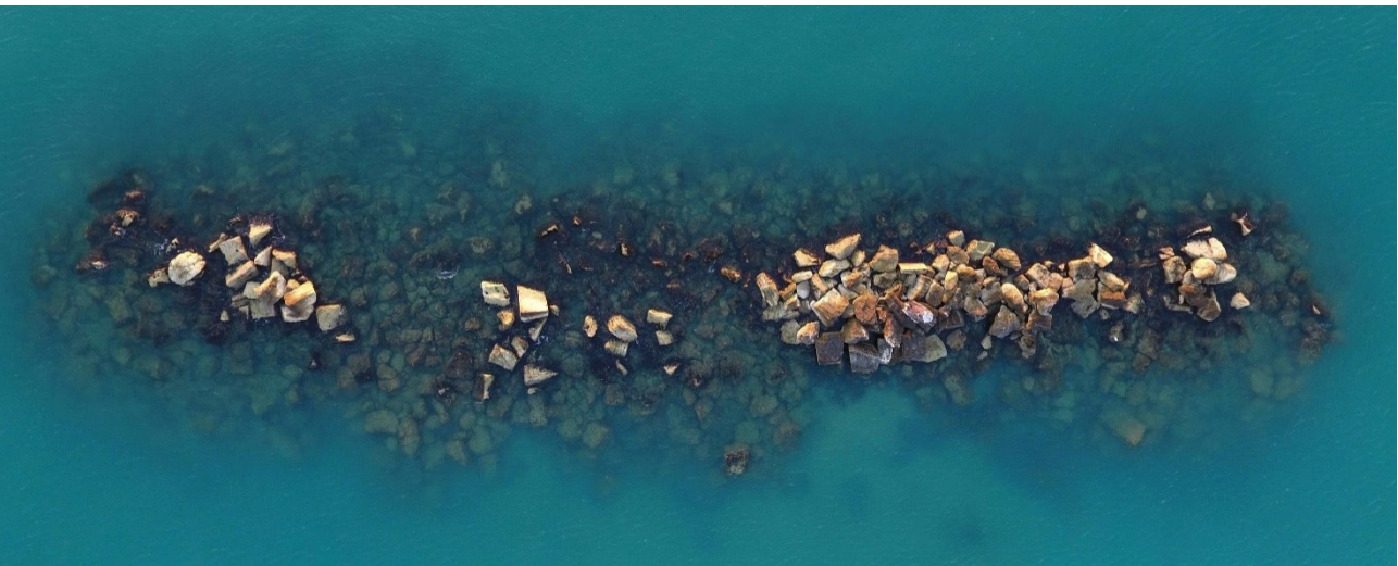
Vista Aerea Scoqliera 14 - 766.SE02
