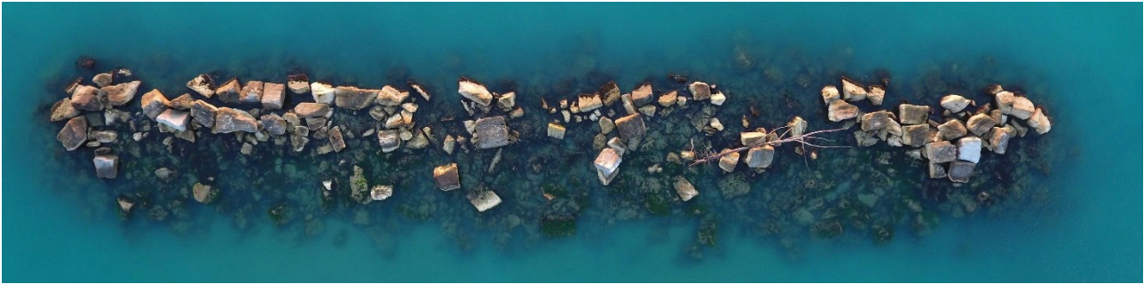
Vista Aerea Scogliera 42 - 756.SE01
