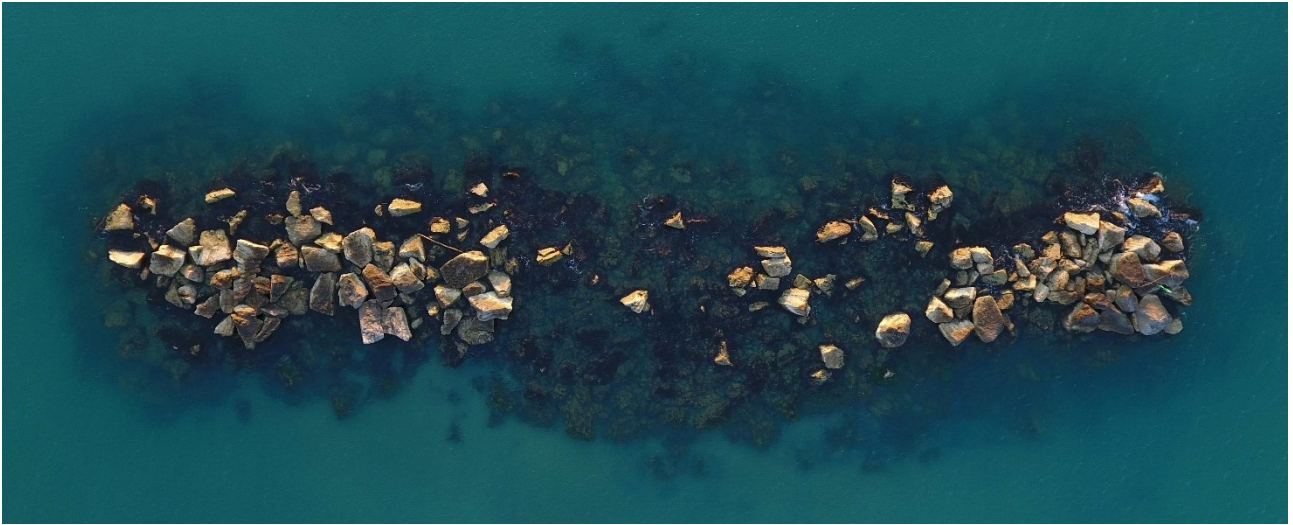
Vista Aerea Scoigliera 19 - 764.SE03
