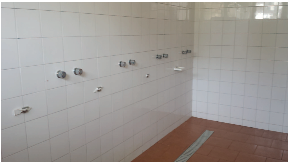
Impianto idrico sanitario - stato attuale zona docce
