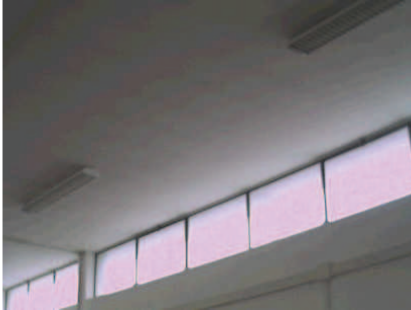
Foto 4a – solaio superiore – immagine reale
